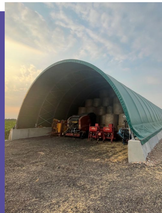
Il tunnel agricolo per il riparo di attrezzi, paglia e fieno
